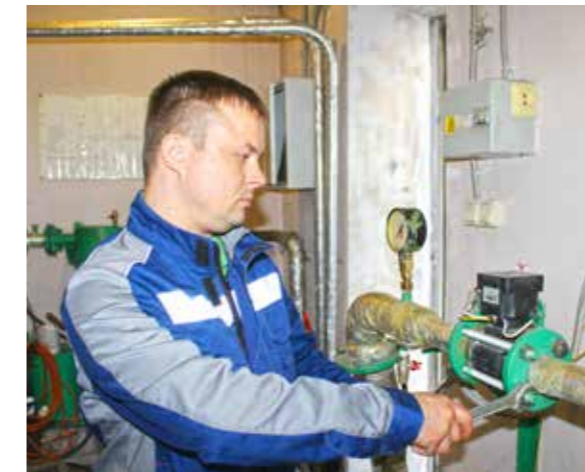
Инженер по метрологии А.С. Терехов производит демонтаж теплосчетчика
