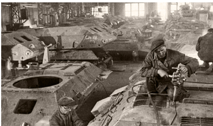
Сборка Т-34 на танковом заводе
