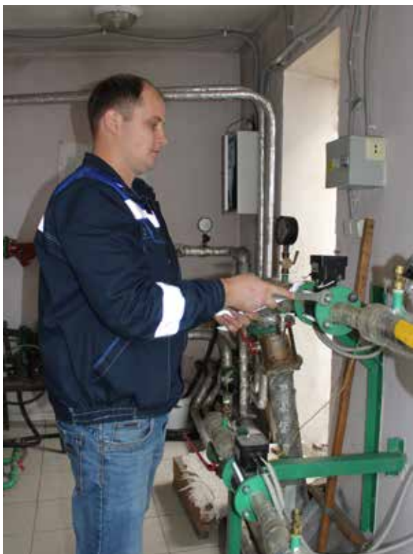
Инженер-метролог Александр Гульба производит монтаж СИ после поверки в узле учета тепловой энергии
