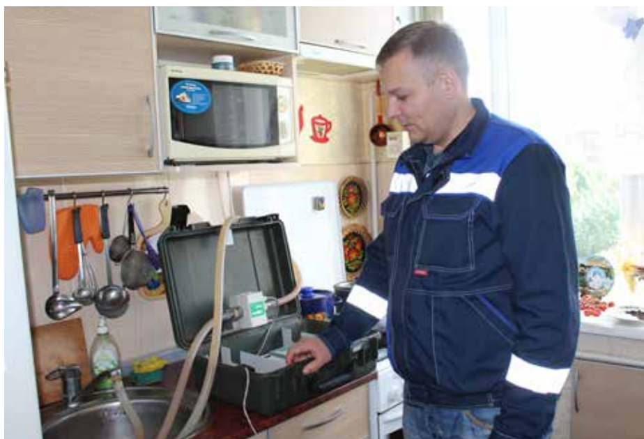
Поверку водосчетчика проводит инженер-метролог Вячеслав Рубанов
