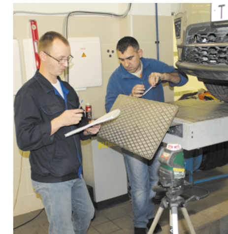
П.А. Мокеев и сотрудник автосервиса выполняют нивелирование подъемника
