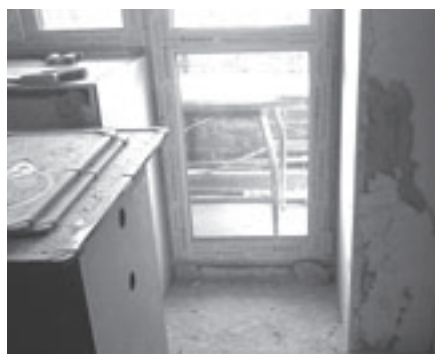
На снимке: одно из мест в квартире, где при помощи тепловизора были выявлены локализованные места промерзания.
