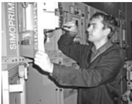
Инженер-метролог И.Подколзин работает на подстанции «Весенняя»
