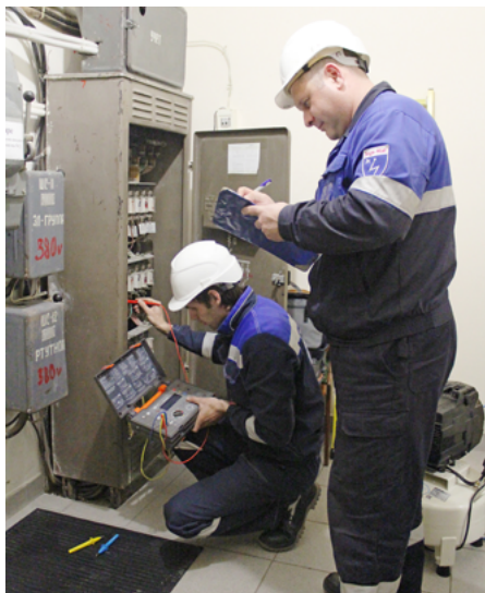
Дмитрий Курчугин и Владимир Шабатура проводят измерения параметров устройств защитного отключения
