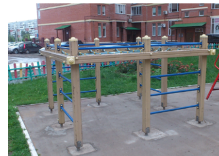
Здесь отсутствует ударопоглощающее покрытие
